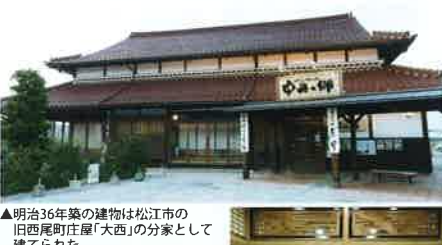
▲明治36年築の建物は松江市の旧西尾町庄屋「大西」の分家として建てられた
