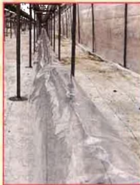
<ビニールのダクト>
